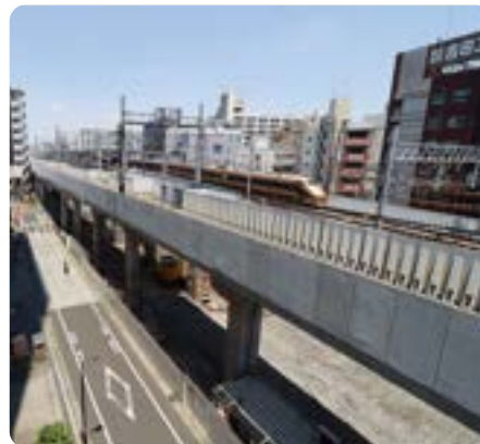
FRP製遮音壁(高欄)
