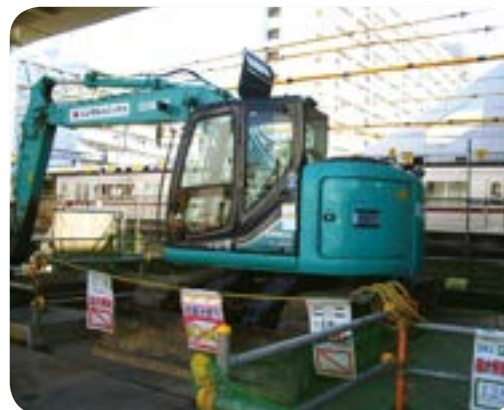
国土交通省より認定を受けている重機
